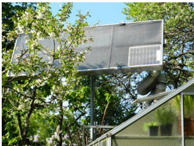
Die Versuchsanlage aus dem Jahr 1994 läuft heute noch problemlos. Die Photovoltaik-Zelle rechts sorgt für Strom zum Antrieb des Warmluftlüfters der Heizanlage des Gewächshauses.
